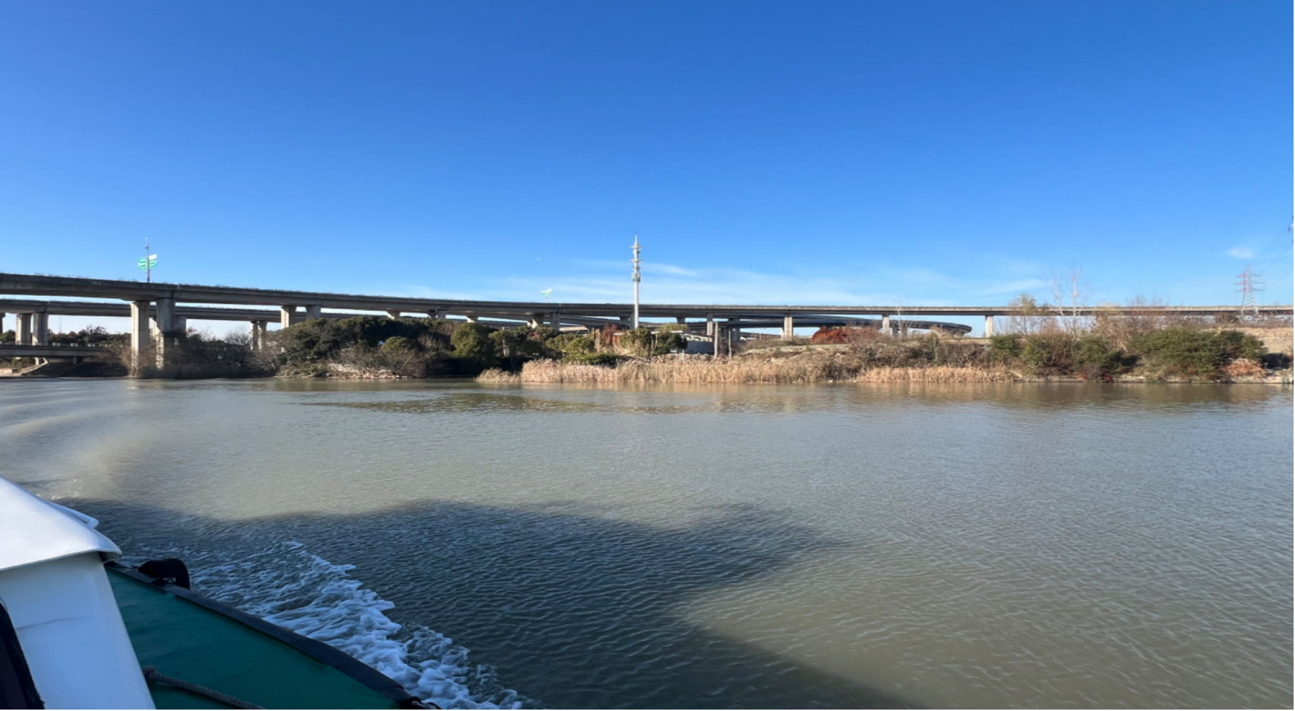
通京大道桥东侧北岸标志牌安装位置现场图：
