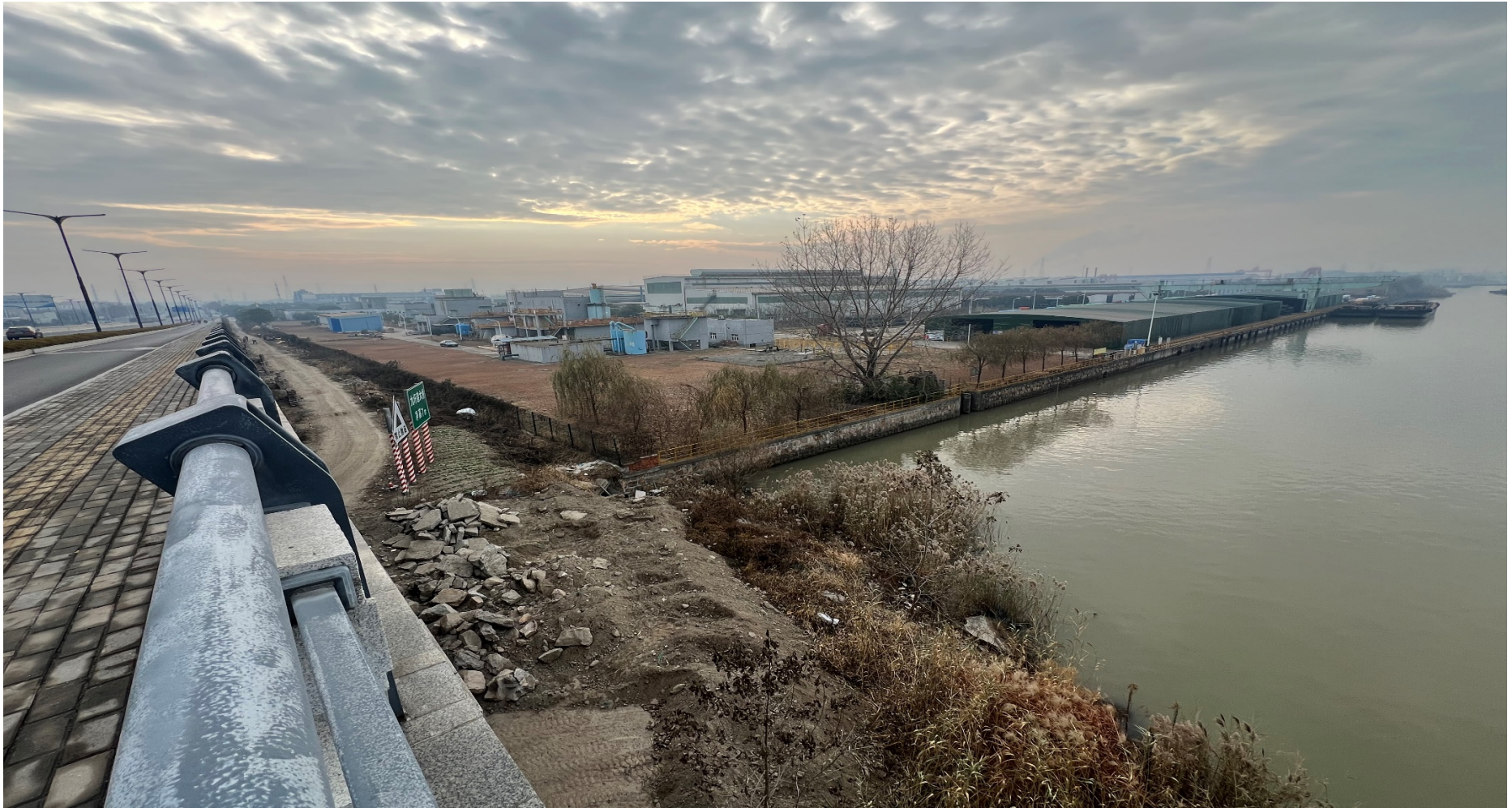
长泰路大桥上游标志牌安装位置现场图：
