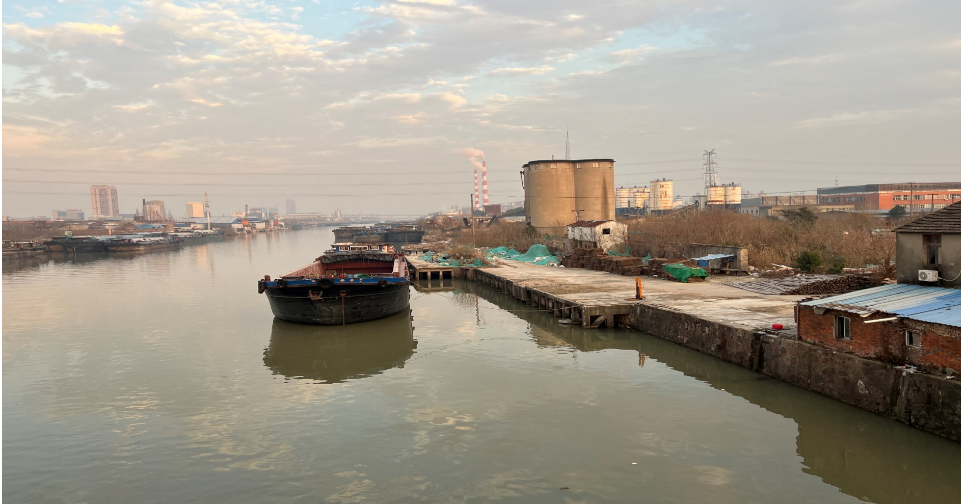
工农路桥东侧南岸标志牌安装位置现场图：
