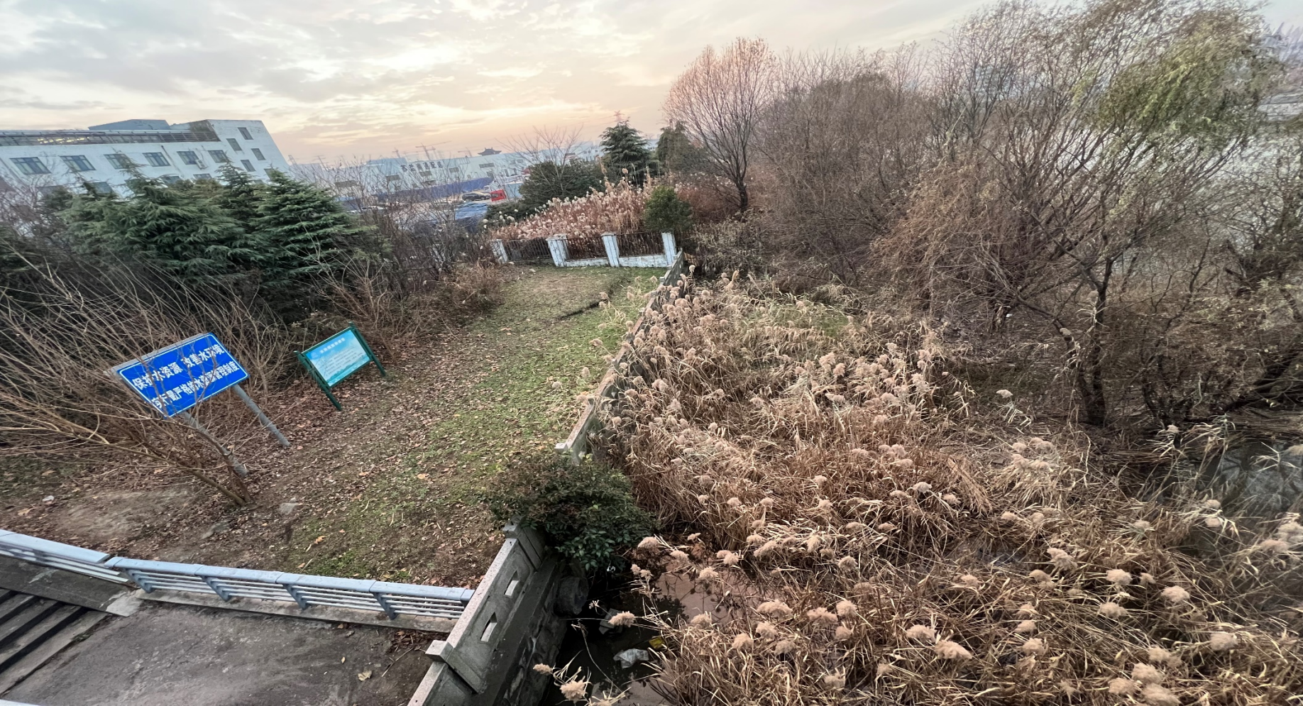
通富大桥西侧南岸标志牌安装位置现场图：
