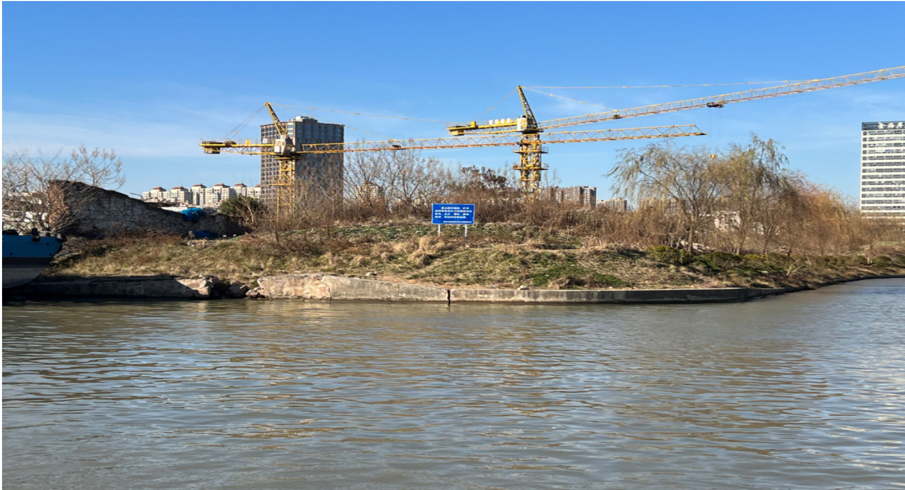
工农路桥东侧北岸标志牌安装位置现场图：
