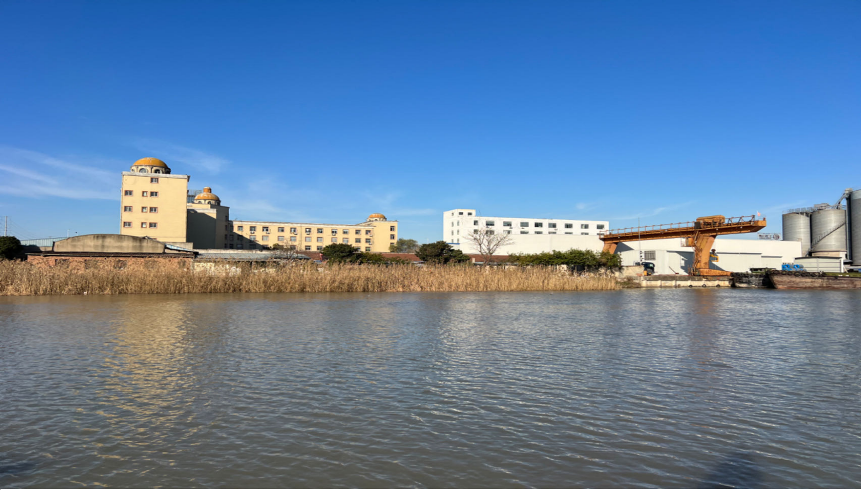
通富大桥东侧北岸安装位置现场图：
