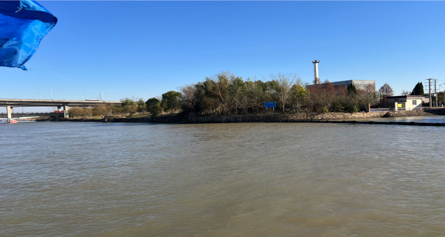
通京大道桥西侧南岸标志牌安装位置现场图：
